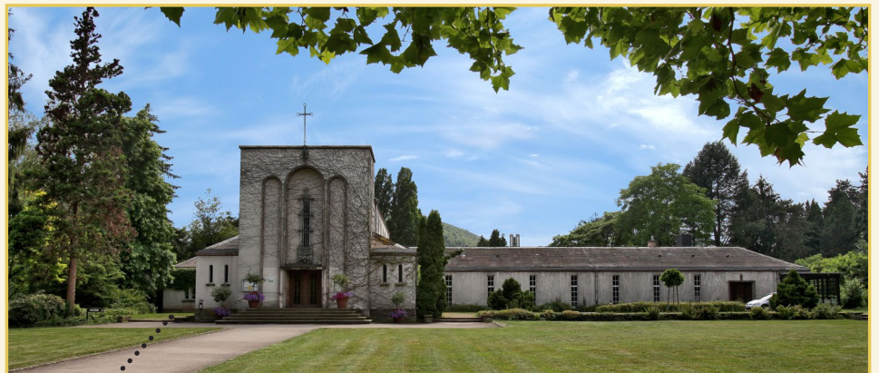
Eingang Kolumbarium, Alte Trauerhalle Hauptfriedhof
